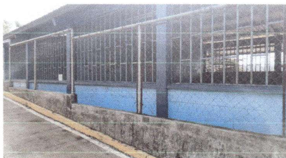
Foto1: Reparación de tubo HG y malla galvanizada
