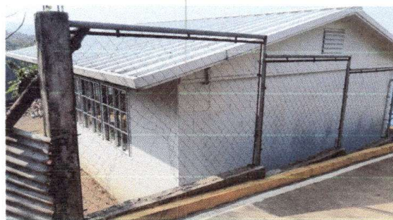
Foto 2: Reparación de tubo HG y malla galvanizada
