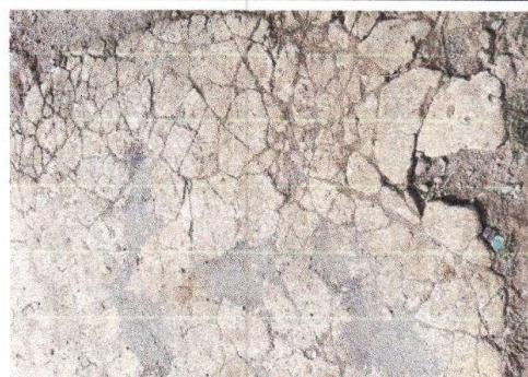
Foto 4: Reparación de plancha de concreto de patio
