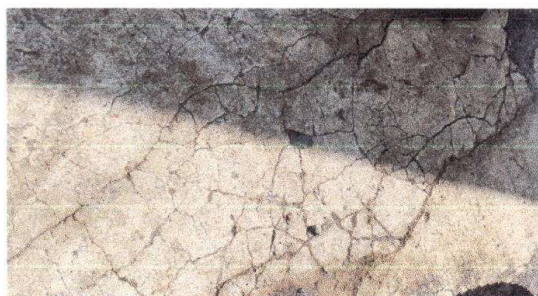
Foto 3: Reparación de plancha de concreto de patio
